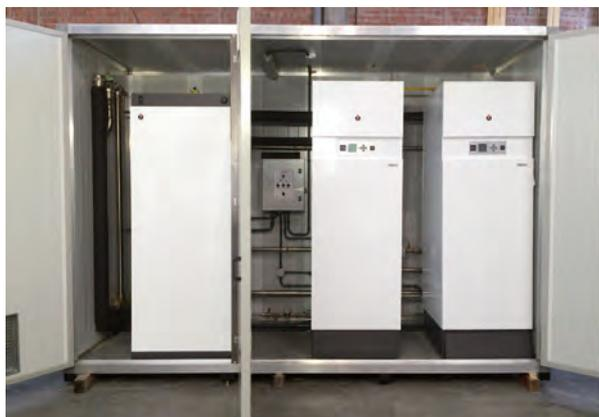
La HeatMaster BOX est un équipement destiné à la production d'ECS (avec une possibilité de double service).
